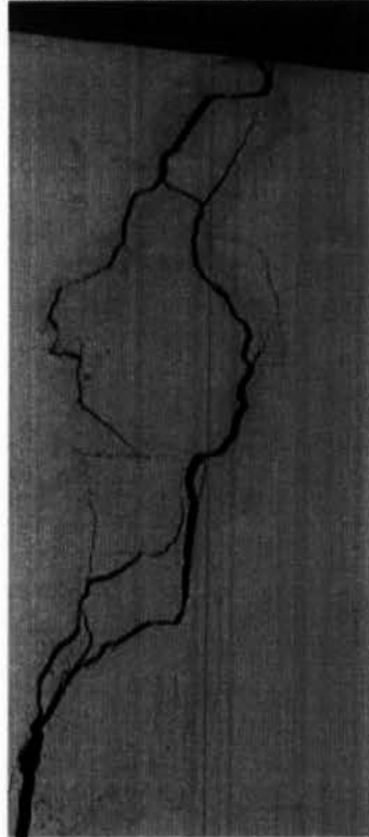
IMAGEM CASO 01 – Identificação de rachadura vertical, espessuras variam de 4 a 7mm
