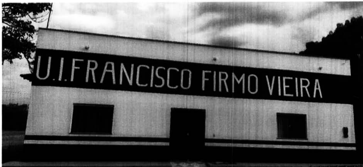
Foto 01: Vista frontal da escola
